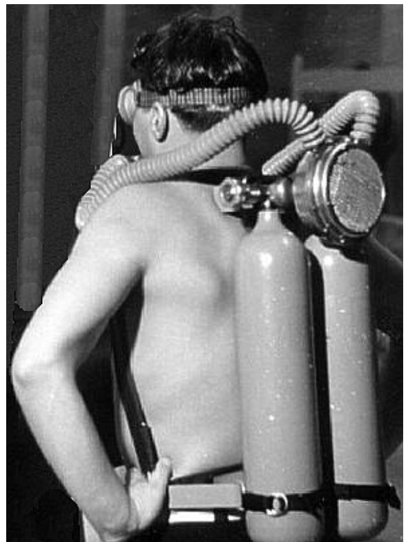
Bild 35: Muster des MEDI713 mit nach hinten stehendem Regler Foto www.wasserwacht-chemnitz.de
