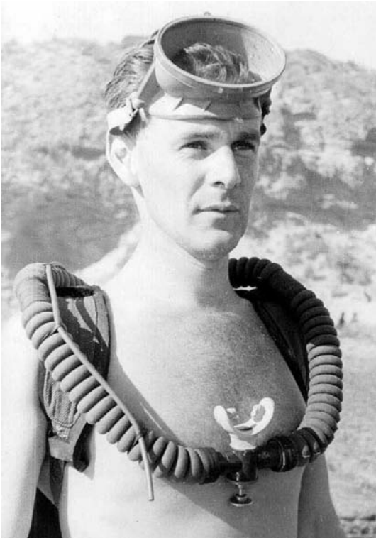
Bill Taylor mit dem MK2-Modell, zeigt den Abströmschlauch des Überdruckventils (Foto: © W. Taylor)
